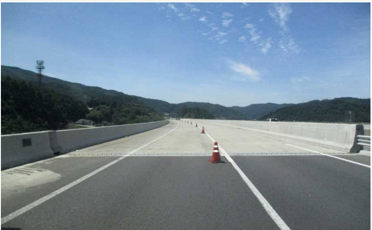
교량 상부 전경
